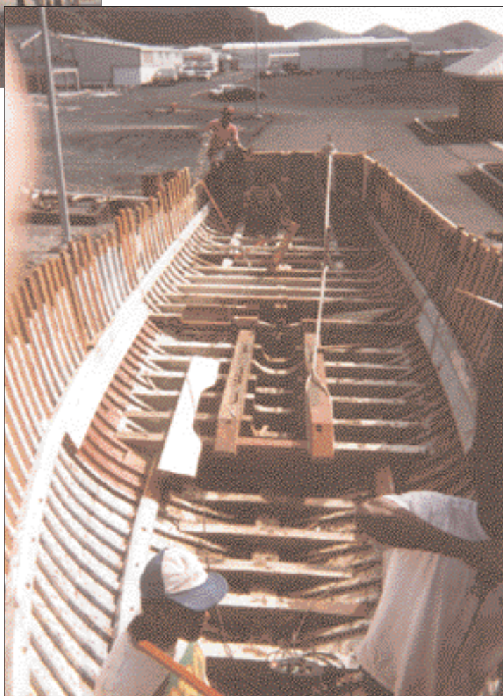
Début de la remise en état de la coque.
